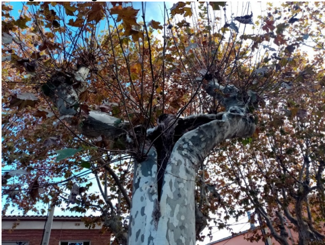
Imatge 2. Zona de la creu on s'aprecia la cavitat i fusta seca al interior.
