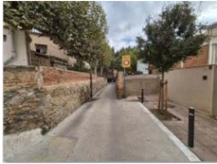
01_Façana a c/Fivaller (afectacio)
