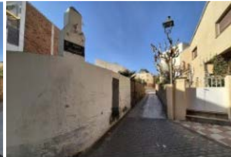
04_Finca part afectada a c/Fivaller
