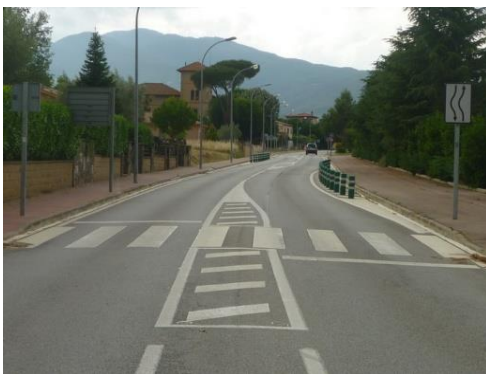
Imatge 39. Exemples de mesures de fàcil aplicació per l'estretament d'amples de calçada
