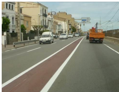
Imatge 39. Exemples de mesures de fàcil aplicació per l'estretament d'amples de calçada
