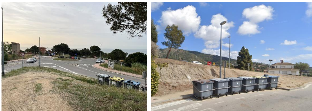
Imatge 33. Tram carrer Migjorn pròxim a la rotonda
