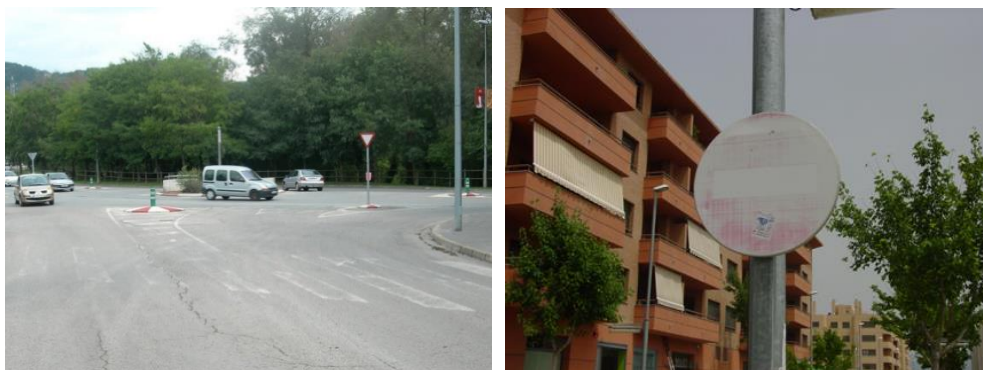
Imatge 45. Senyalització en estat deficient
