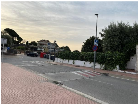
Imatge 1. Passeig del Castanyer, pas de vianants elevat.
