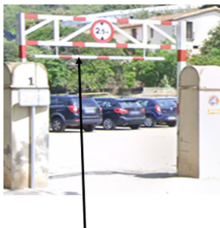
Limitador d'alçada que s'hauria de posar
